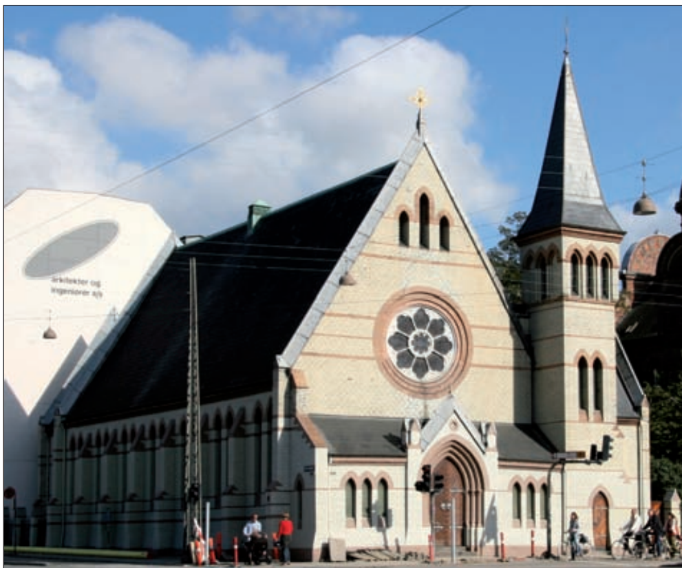
Den Katolsk Apostoliske Kirke ligger meget flot ved søerne på hjørnet af Gyldenløvesgade (i forlængelse af H. C. Andersens Boulevard) og Nørre Søgade. Den er bygget i 1871 i engelsk nygotisk stil. Oprindeligt lå den frit i det, der dengang var udkanten af København. Nu har den bl.a. Dannerhuset til nabo.
