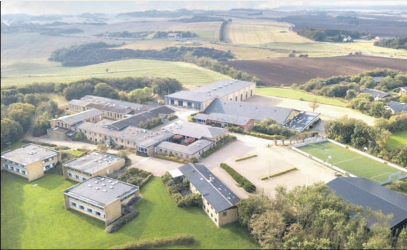
Den nedlagte idrætsefterskole omfatter mange bygninger - og haller med plads til 2.000 personer.
